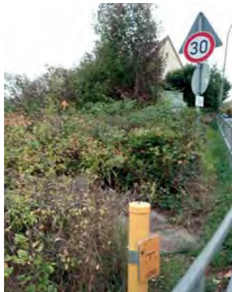
Freistellung und Schutz von technischen Einrichtungen.
